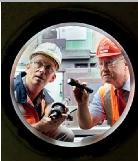
Un travail d'équipe dans sa forme la plus pure : Willi Spelter (RWE) et Norbert Ophüls (DST) collaborent étroitement lors du retrofitting
