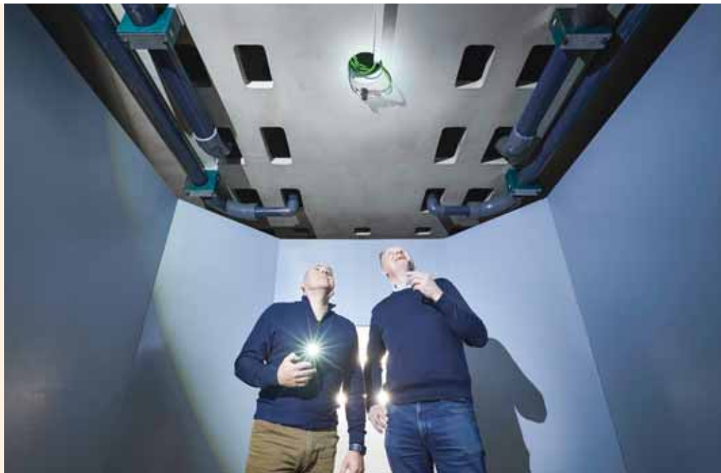
Vue sur le tunnel : Hubert Erz, consultant senior Ventes/Énergies renouvelables de Starrag, et Henning Albrechtsen, directeur de HACO, inspectent la nouvelle catacombe high-tech sous le centre de cet imposant plateau rotatif.
