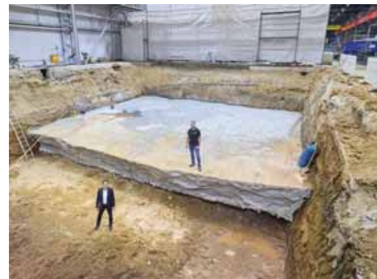
Actuellement, des préparatifs visant à réaliser une fondation sur laquelle sera construit un nouveau centre d'usinage à grande échelle Droop+Rein FOGS HD à l'automne sont en cours.
