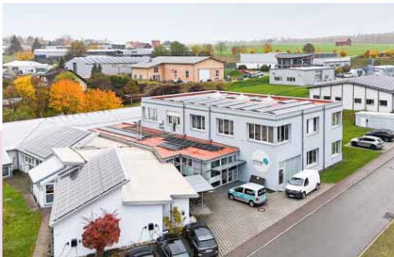
Cette entreprise, située à Neuhausen ob Eck, en Allemagne, emploie une centaine de personnes et dispose d'un parc de machines moderne.
